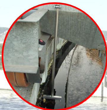
Mât de nettoyage doté de buses à jets directionnels
