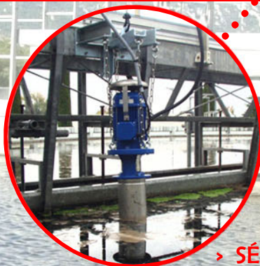
Mât de nettoyage doté de buses à jets directionnels
